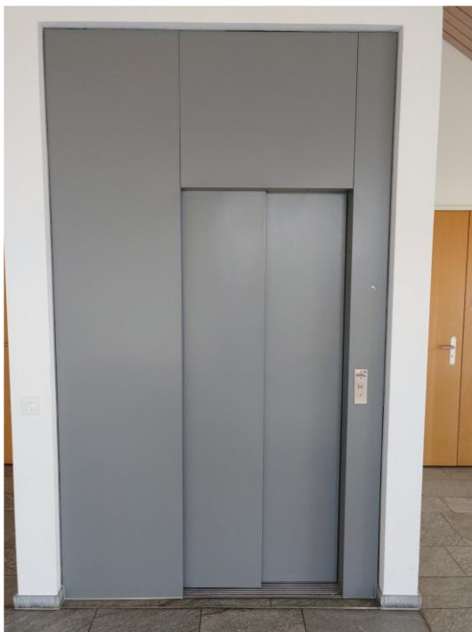
Lifteingang im EG
